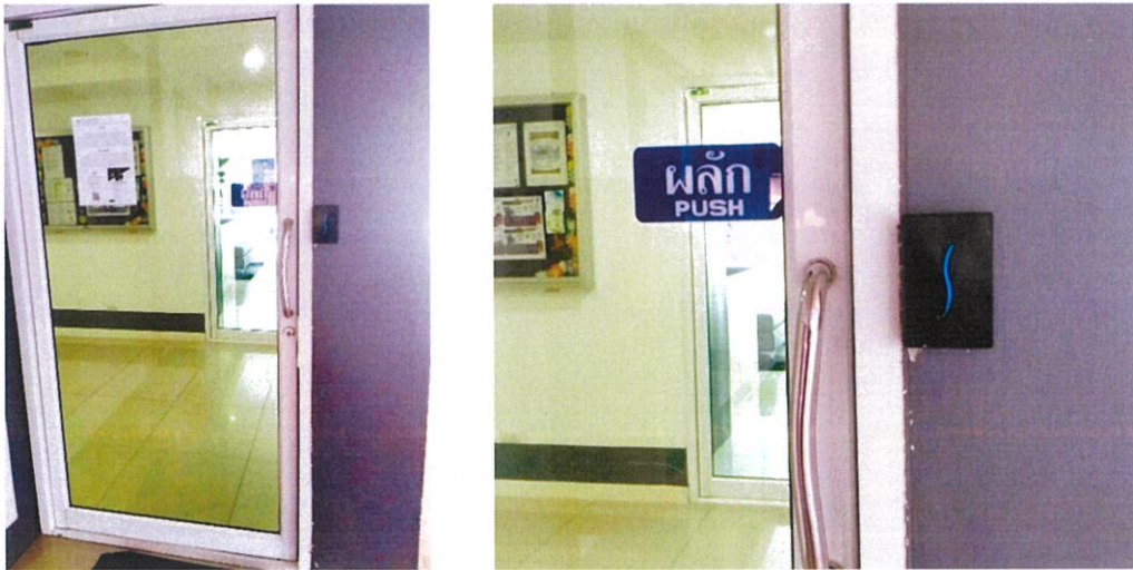
รูปที่ 3-45 ติดตั้งระบบ access control ด้วยระบบ keycard บริเวณประตูทางเข้า-ออกอาคาร
