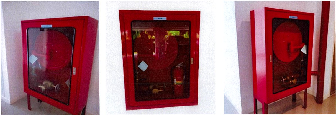
รูปที่ 3-31 ตู้เก็บสายฉีดน้ำดับเพลิงพร้อมอุปกรณ์ (Fire Hose Cabinet : FHC)
