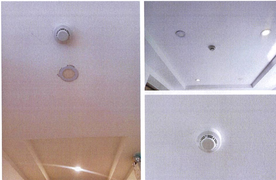
รูปที่ 3-32 อุปกรณ์ตรวจจับควัน และอุปกรณ์ตรวจจับความร้อน
