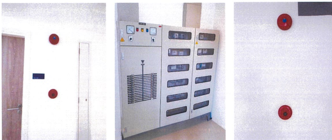
รูปที่ 3-34 อุปกรณ์แจ้งเหตุไฟไหม้กริ่งส่งสัญญาณเตือนอัคคีภัย (Fire Alarm Bell) และแผงควบคุม (Manual Station)
