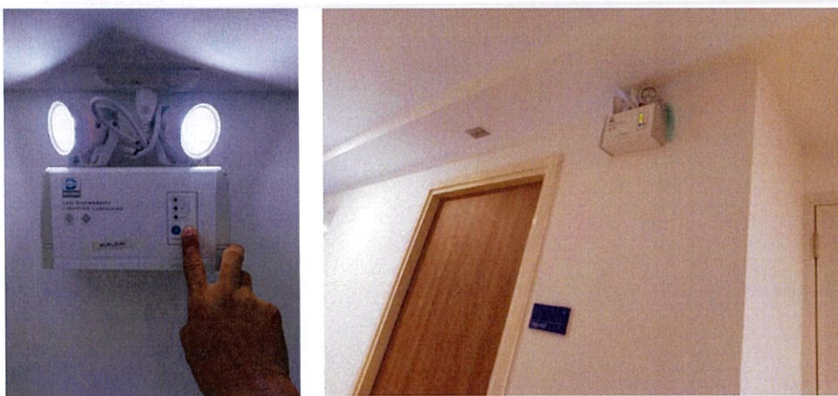
รูปที่ 3-33 ไฟฉุกเฉินอัตโนมัติชนิดแบตเตอรี่แห้ง
